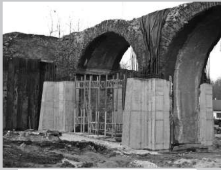
Épül a viadukt
